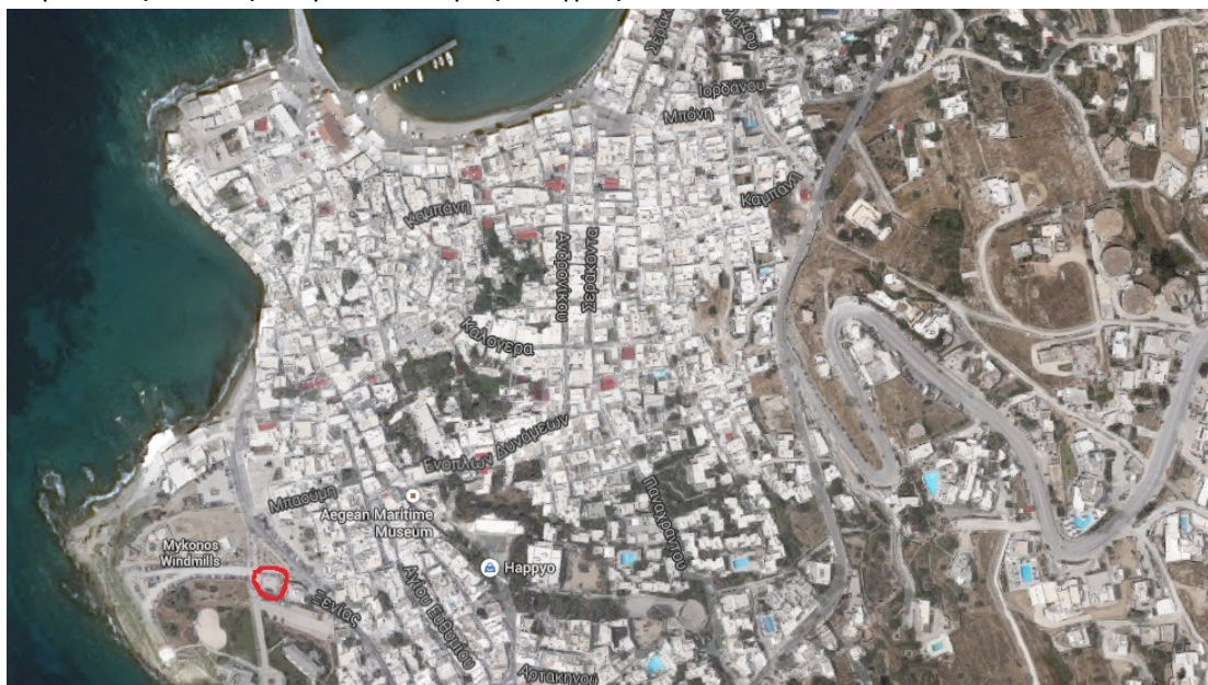
Εικόνα 7: Αεροφωτογραφία οικισμού Χώρας.
